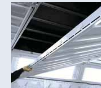
Possible opening and ceiling filters replacement. Posibilidad de apertura y sustitución del filtro de techo.
